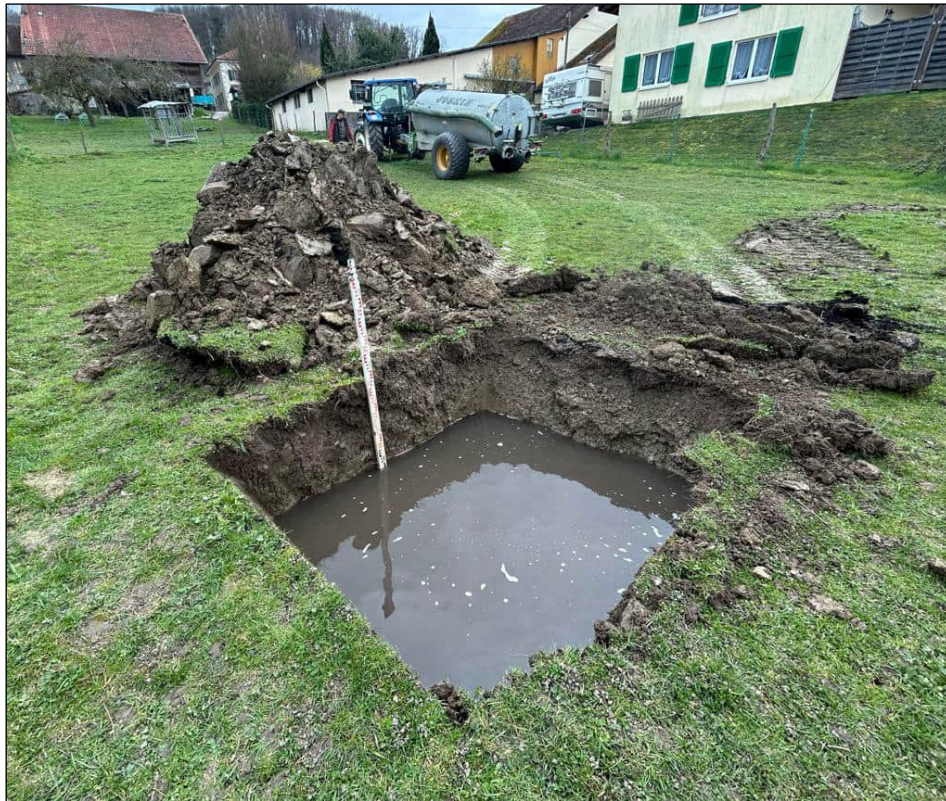
Figure 4 : Photographie de l'essai d'infiltration
