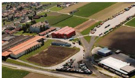
Secteur logistique: bâtiment Planzer, Terco et faisceau de voies ferrées desservant le site (image: PESA)
