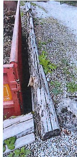
Des volets ont été fixés sur les derniers troncs afin de combler le vide et garantir la sécurité des usagers entre le quai et la benne.
